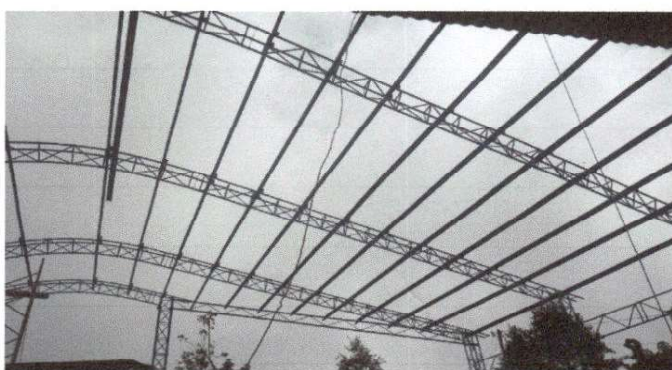
Foto 5: Estructura de techo
