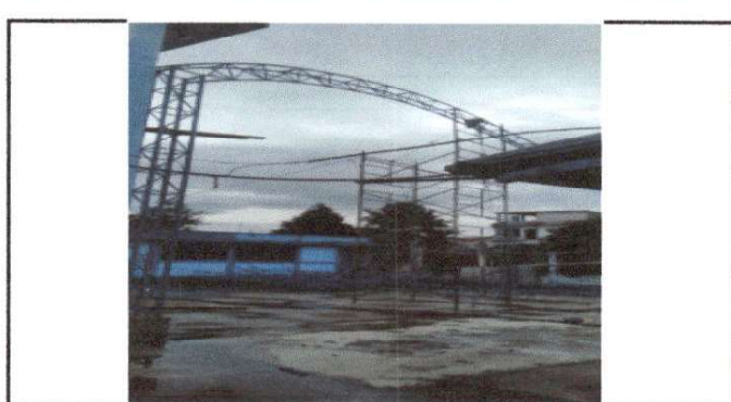
Foto 6: Estructura de techo
