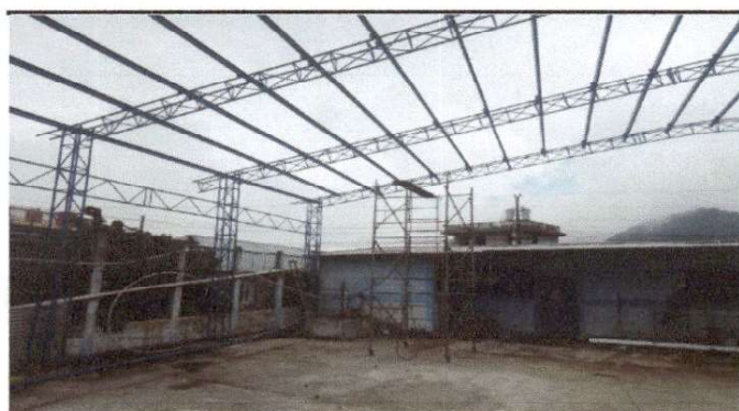
Foto 3: Estructura de techo
