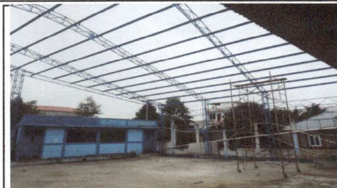
Foto1: Estructura de techo
