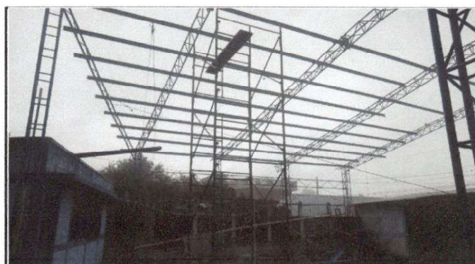
Foto 4: Estructura de techo
