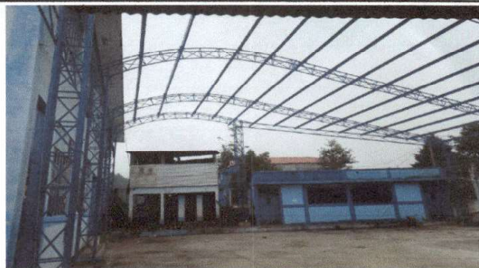
Foto 2: Estructura de techo
